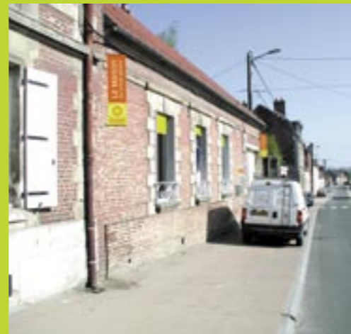
Maisons du Conseil général de Ressons-sur-Matz (en bas) et la nouvelle Maison de Nanteuil-le-Haudouin (en haut)
