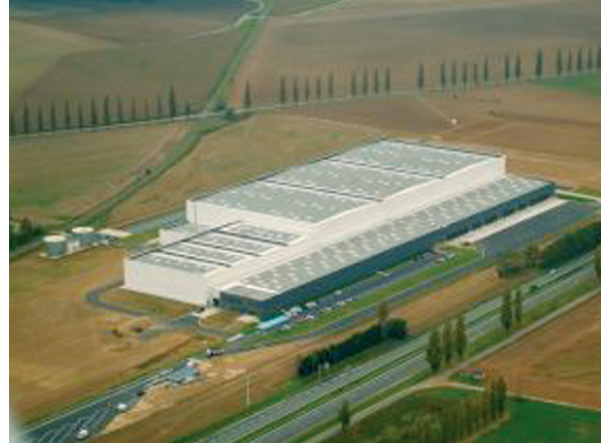
Vue aérienne de la zone industrielle de Bresles
