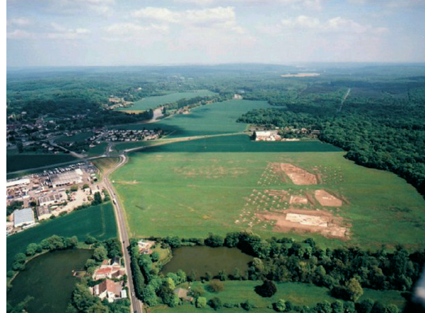
Implantation d'un bassin d'atténuation des crues à Choisy-au-Bac
