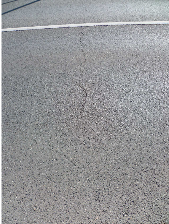
Fissure de 1,5 cm sur le Pont de Paris
